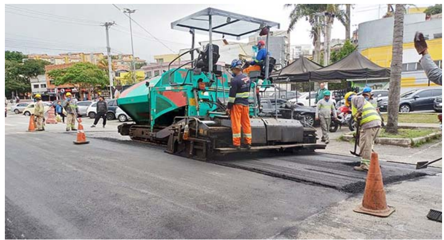
As obras incluem a remoção do pavimento antigo (fresagem) e a aplicação de uma nova camada de asfalto
